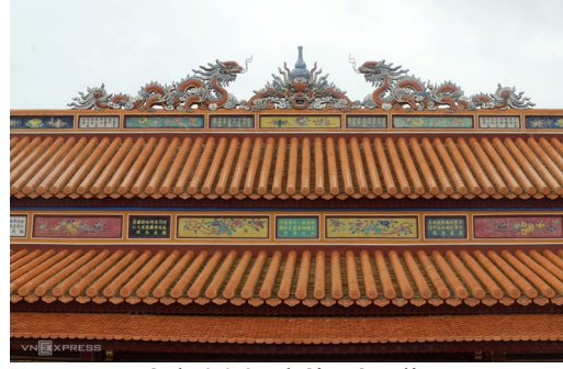
Hình 94.2 Thái Hòa điện
